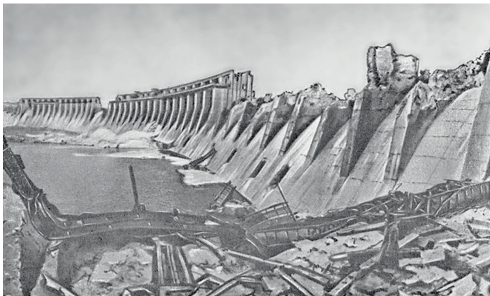
Разрушенная плотина Днепровской ГЭС
