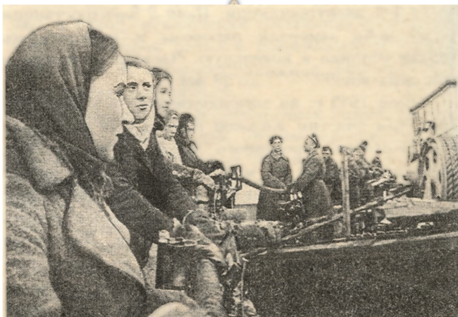
Укладка кабеля с барабанов на баржу
