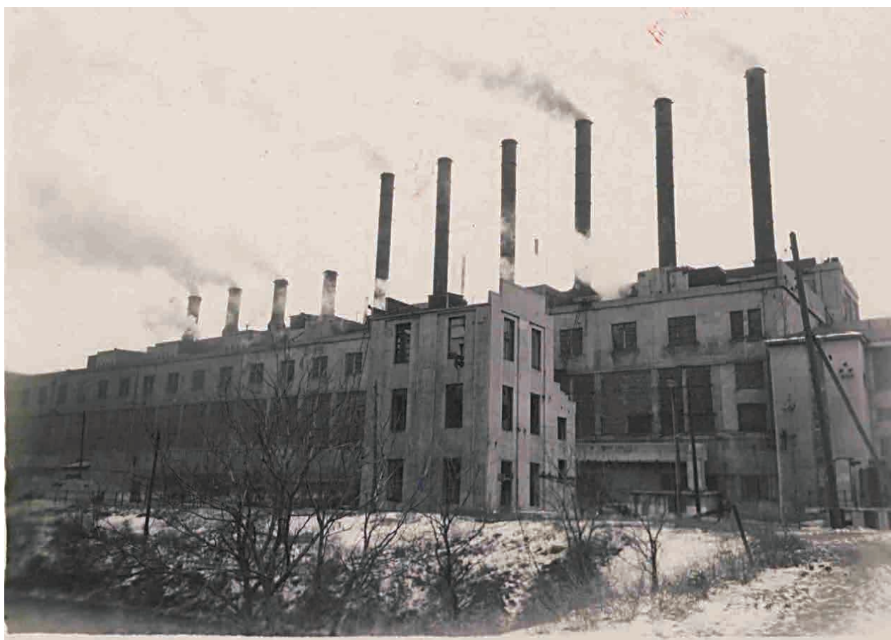
Шахтинская ГРЭС. Вид на пылезавод и главный корпус, 1950-е годы
