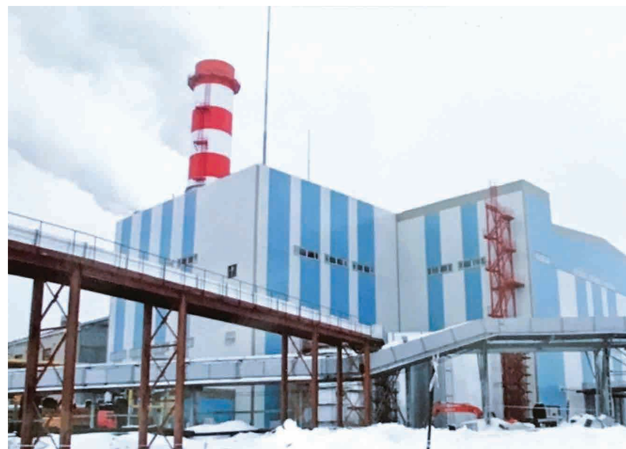
Вид на главный корпус Кировской ТЭЦ-5
