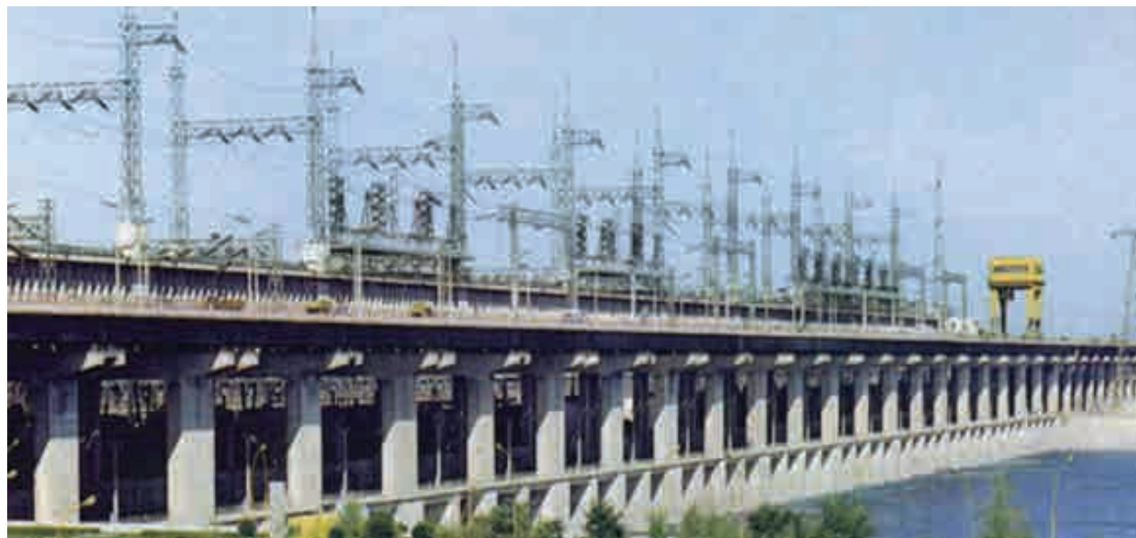
Плотина Сталинградской ГЭС
