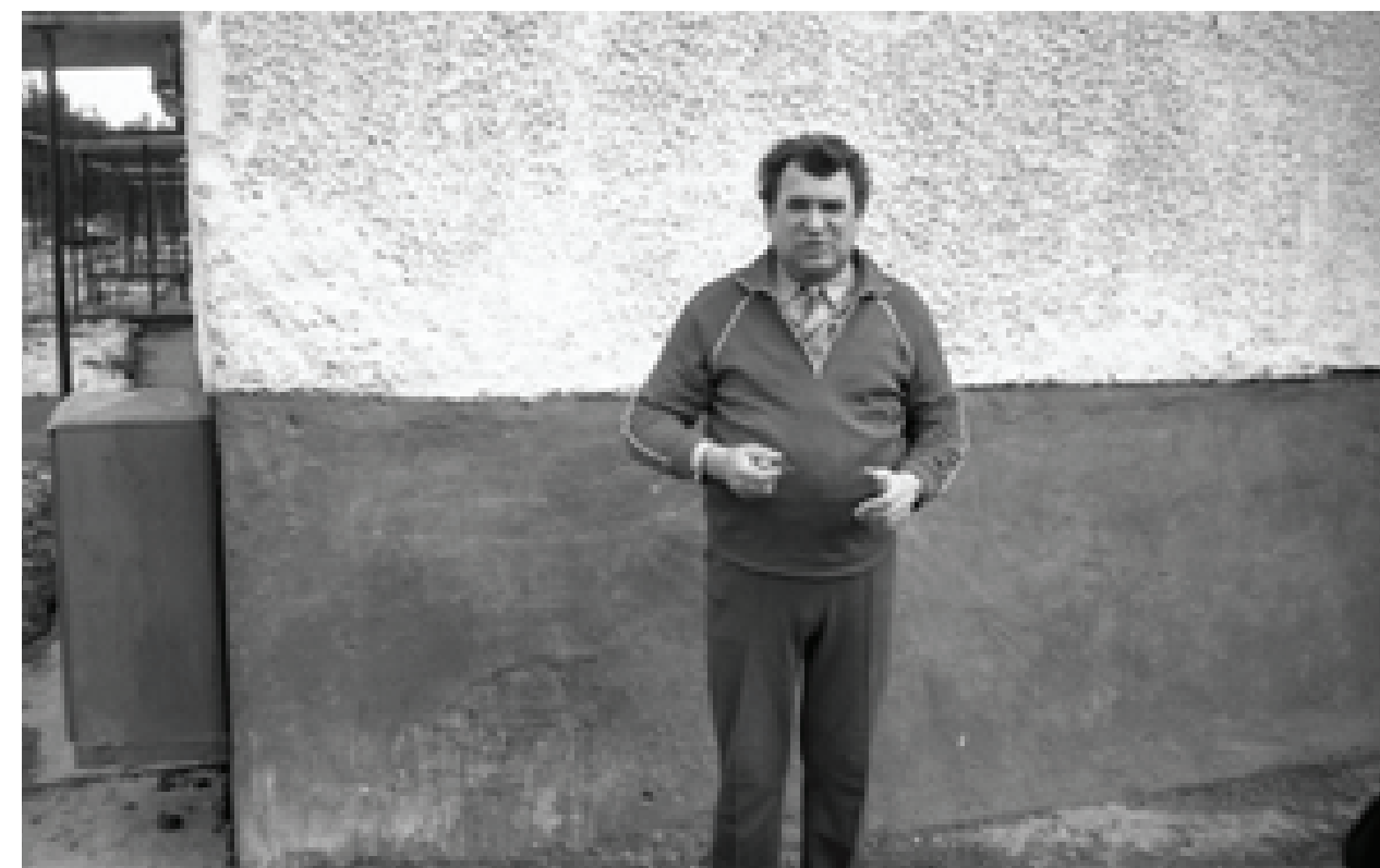
Сургут. В городе. Шаповалов Виктор Пантелеевич. Шеф – инженер Таганрогского котельного завода. Надзор за монтажом парогенератора на Сургутской ГРЭС – 2, 1986 год
