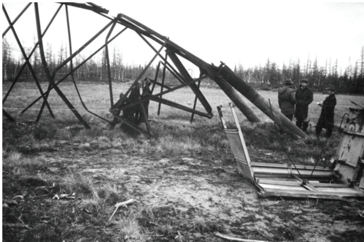
г. Уренгой, упавшая опора, Земля вытолкнула забитые сваи, 1985 год
