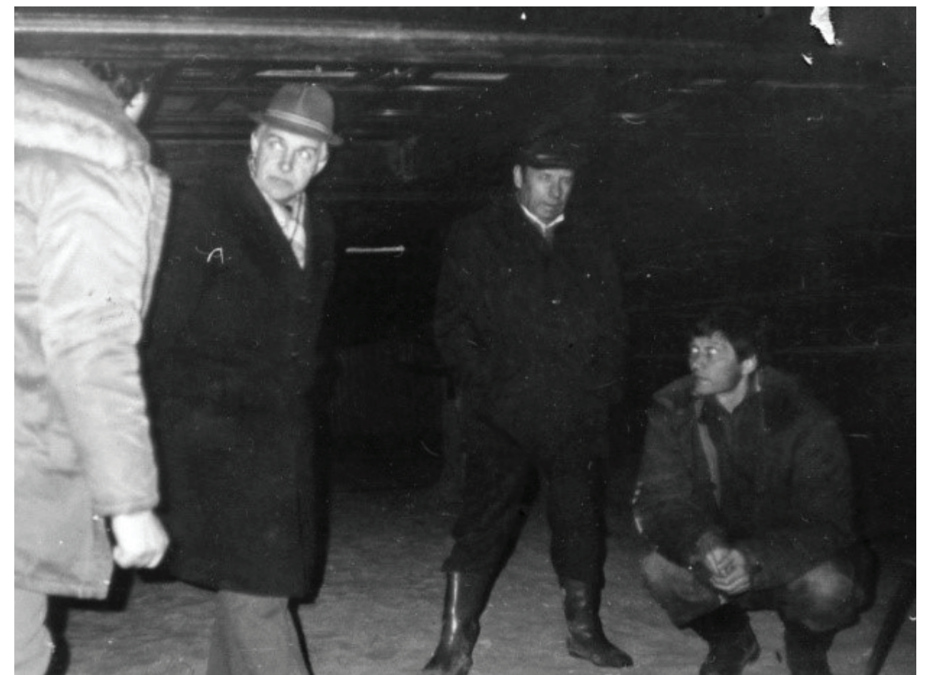
г. Уренгой, Надым, ГРУ. Еще одна компоновка кабельного полуэтажа. Опять не очень удачная. Мала высота до потолка, 1988 год
