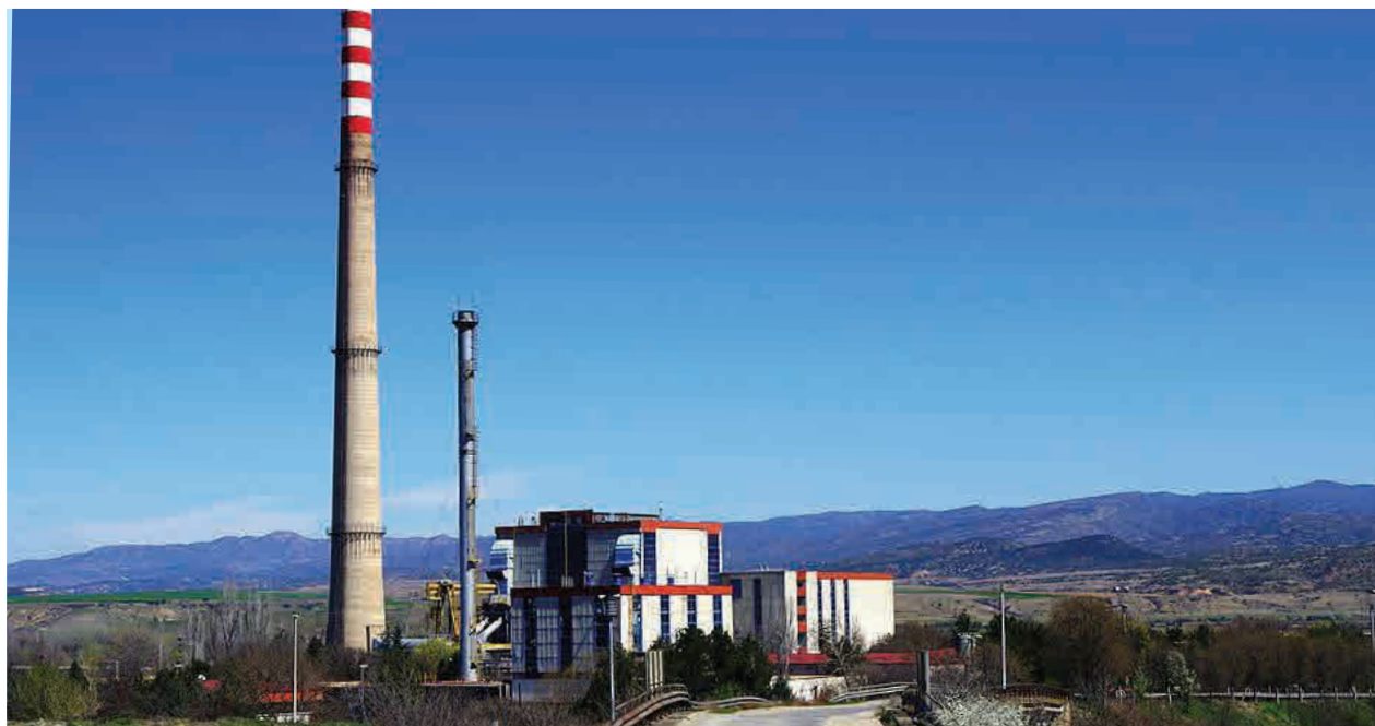
ТЭЦ «Неготино» (Югославия)
