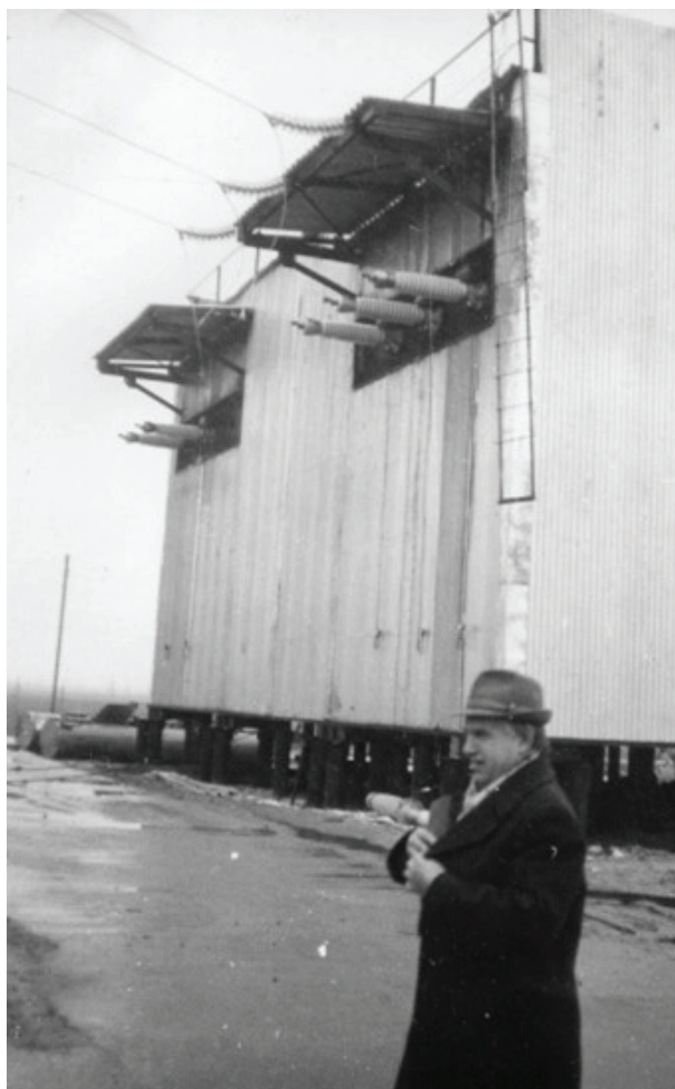
«Тюменьэнерго» г. Уренгой Новая подстанция, И. А. Новожилов, 1985 год
