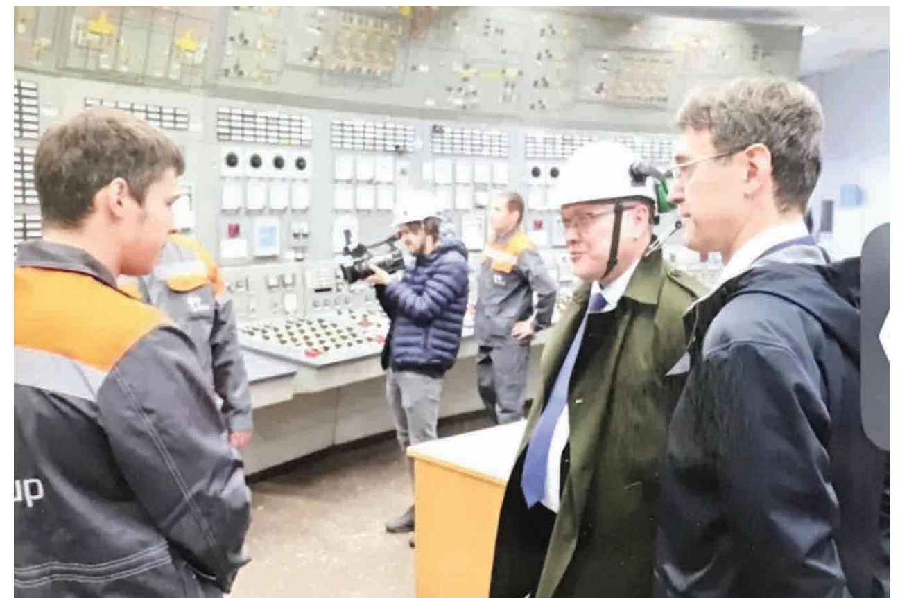
Губернатор Кировской области Соколов на главном щите ТЭЦ-5
