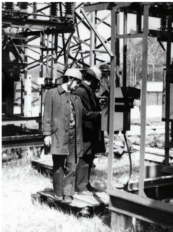
На подстанции Вятка
