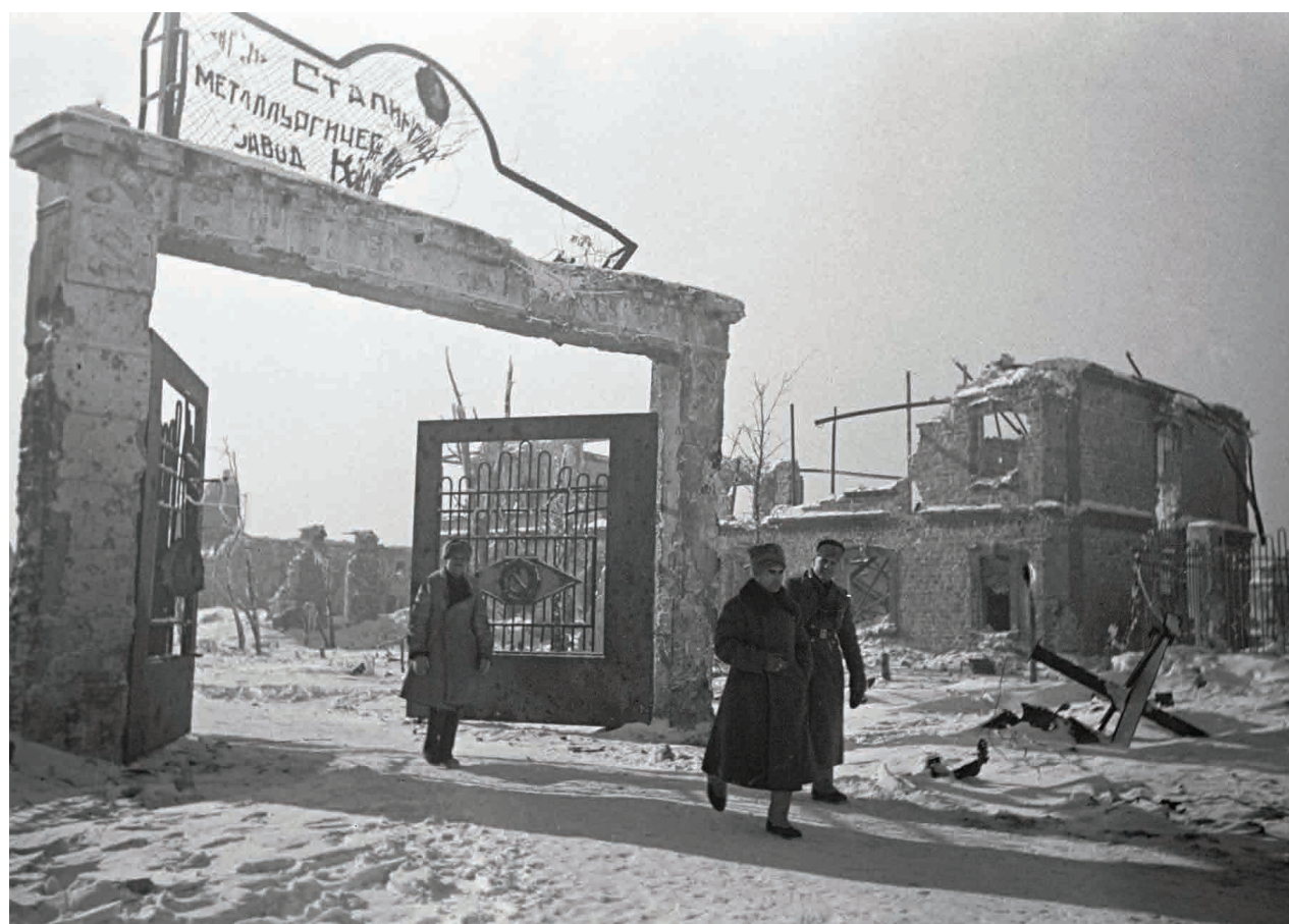
Проходная, остатки заводууправления и ЦЗЛ завода «Красный Октябрь»
