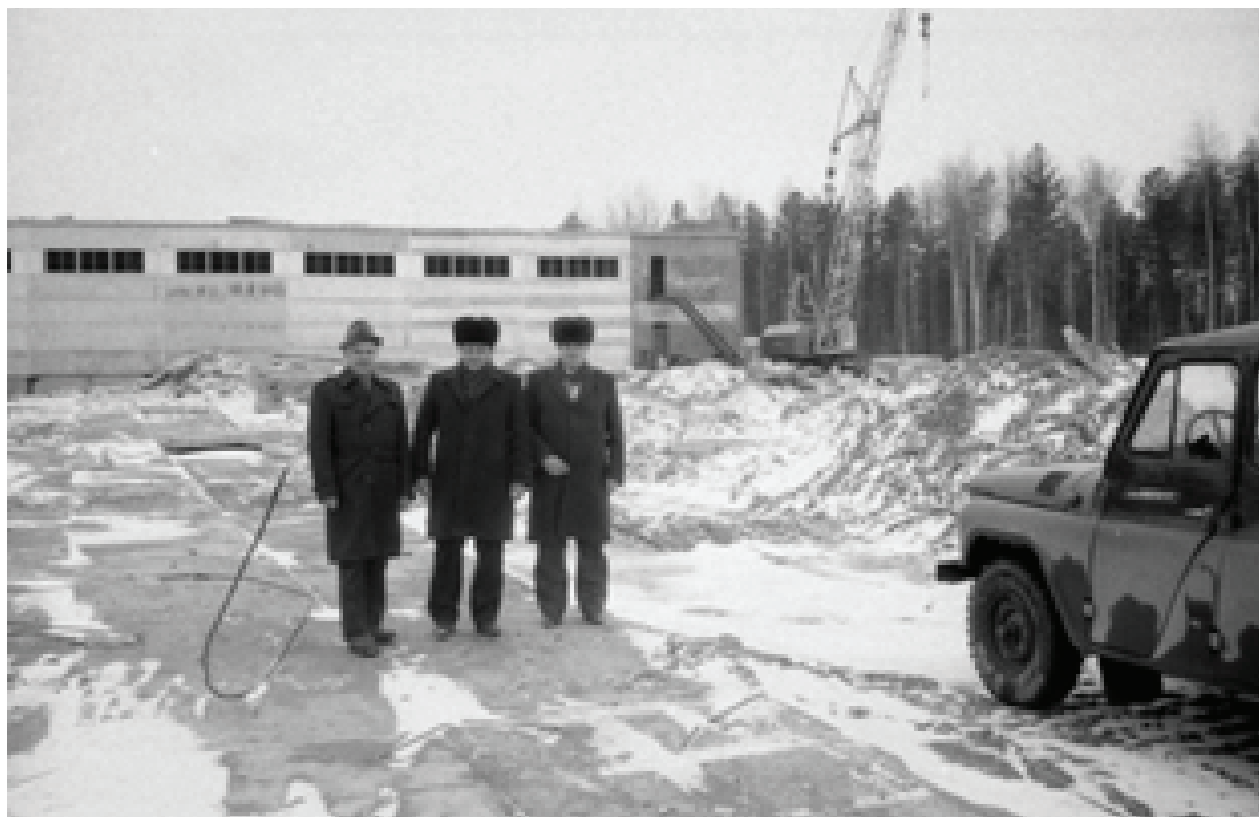
г. Нижневартовск, строится подстанция Кутовая И. Новожилов, Е. Черников, Колмаков провели её осмотр, 1986 год
