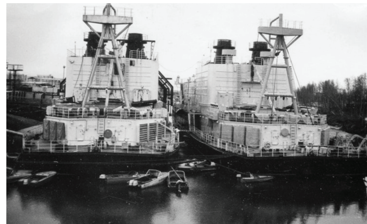
«Тюменьэнерго» г. Надым. Две газотурбинные электростанции Газпрома ПДЛЭС – 05 и ПЛЭС – 06, 1985 год
