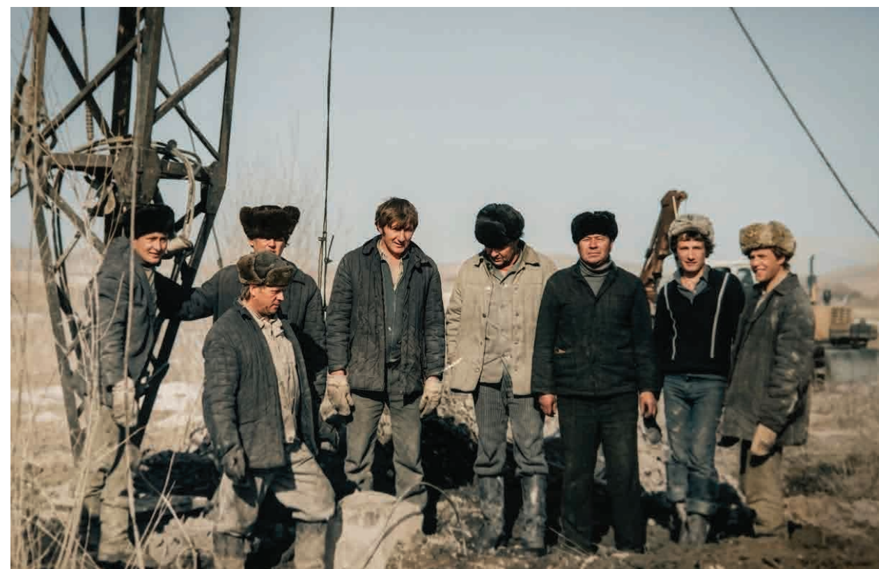
Часть бригады РМС, выполнявшей эту сложную и предельно опасную работу. В центре стоит, опустив голову от дум, начальник РМС Тувинских электрических сетей РЭУ «Красноярскэнерго» С. Б. Сараев
