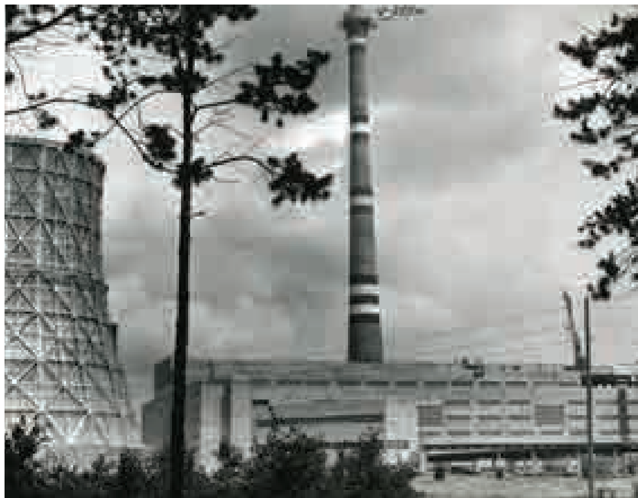
г. Тюмень, стройка Тюменской ТЭЦ – 2, трубопроводы подачи воды на город в системе отопления проложены по поверхности земли, 1986 год
