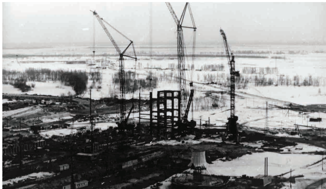
Строительство Нижневартонской ГРЭС
