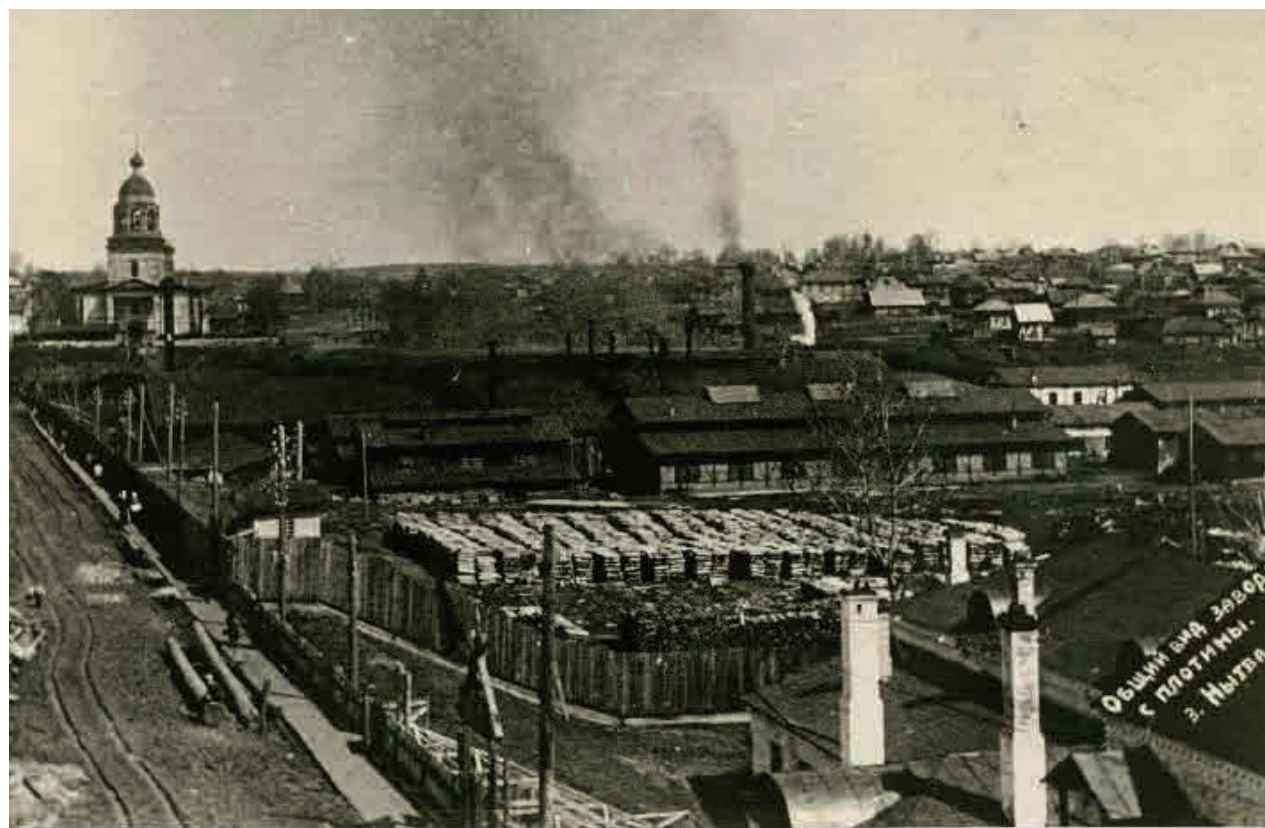
Общий вид завода с плотины, г. Нытва
