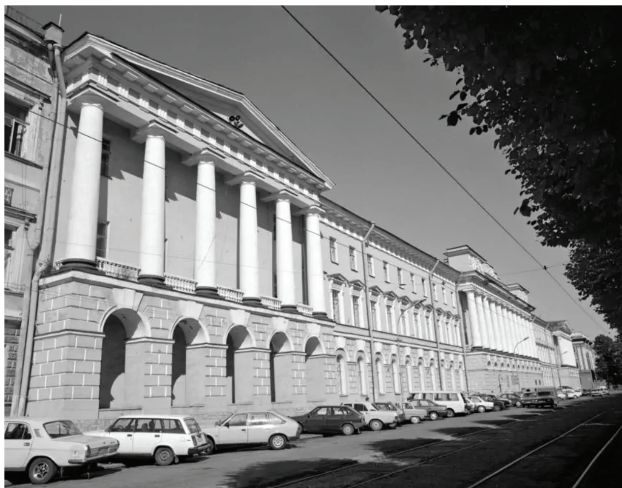
«Ленэнерго», г. Ленинград
