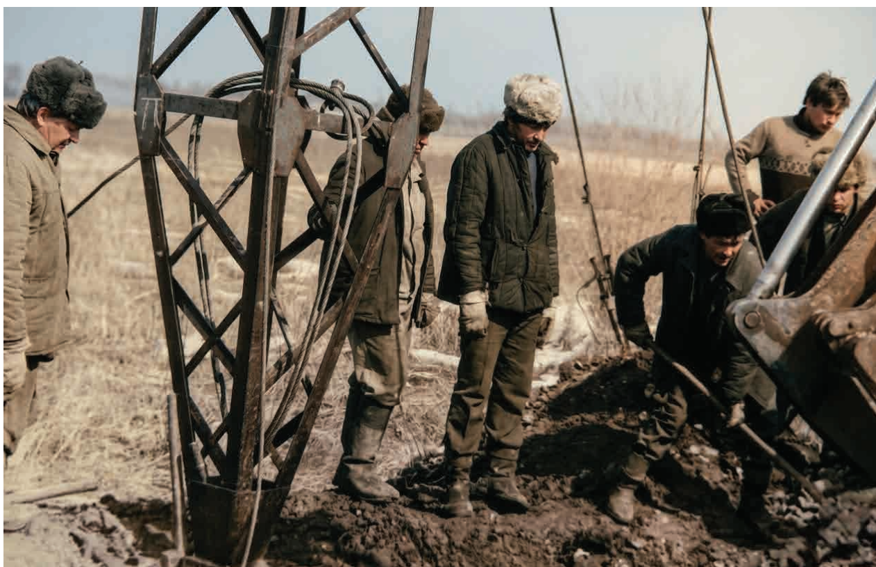
Правая аварийная стойка снята с аварийного фундамента и установлена на временную металлическую площадку. Слева от стойки стоит начальник РМС Тувинских электрических сетей РЭУ «Красноярскэнерго» С. Б. Сараев
