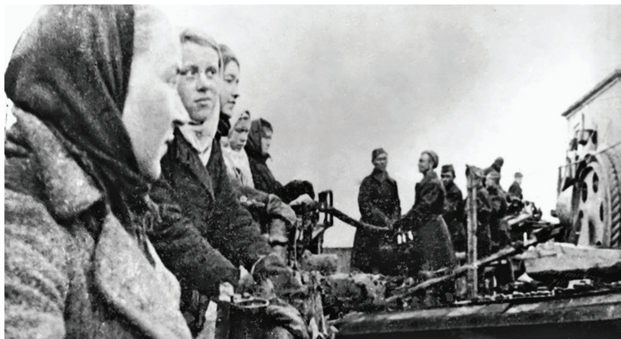
Укладка подводного «кабеля жизни»
