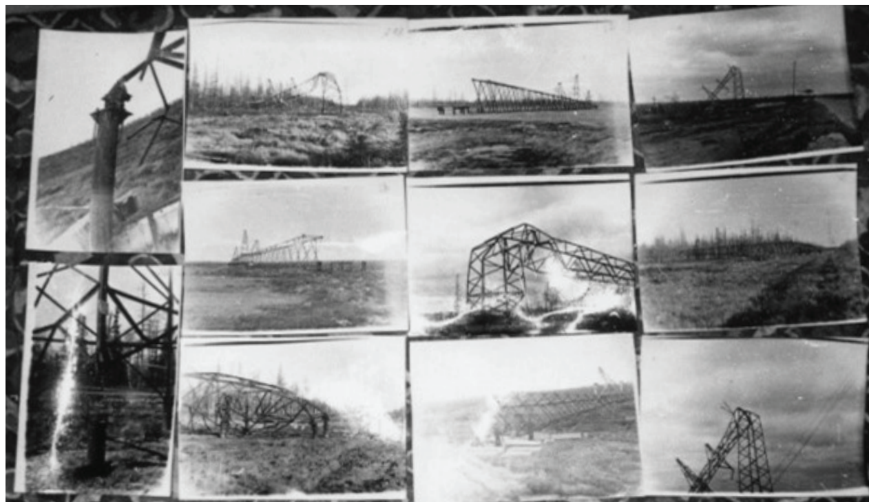
На подстанции Пангоды создан стенд упавших опор, Работает комиссия, 1985 год
