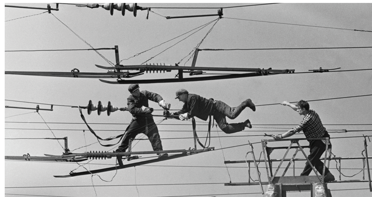
Протяжка новой линии ЛЭП в сторону Выборга
